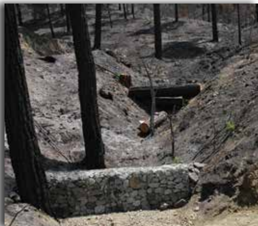
Γαβίον και κορμοφράγματα Σολιά
